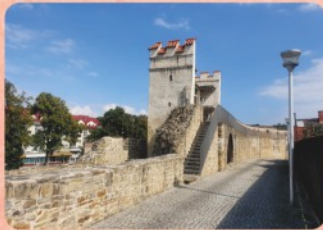
14 | Renesančná bašta The Renaissance Bastion
