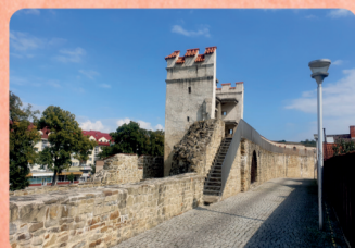
14 | Renesančná bašta The Renaissance Bastion
